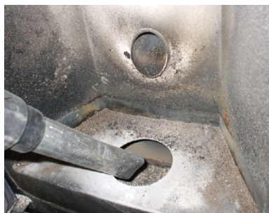
Fig. 33 - Nettoyage brasero
