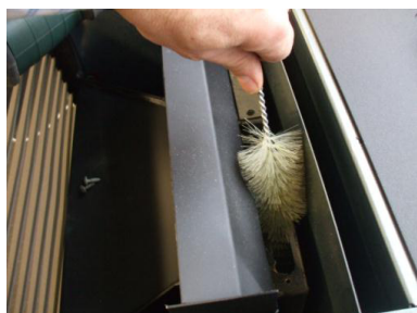
Fig. 45 - Nettoyage du canal
