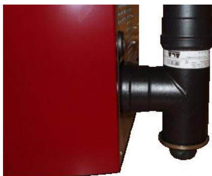
Fig. 39 - Nettoyage du collecteur des fumées
