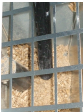
Fig. 36 - Nettoyage réservoir et vis sans fin
