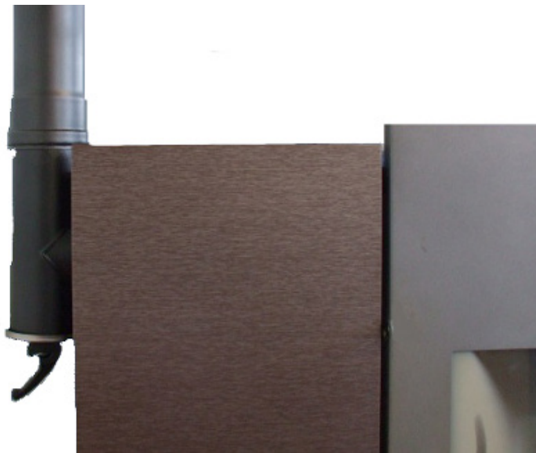
Fig. 46 - Limpeza do canal de fumo
