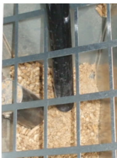
Fig. 45 - Limpieza depósito y coclea
