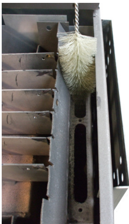
Fig. 53 - Nettoyage du canal
