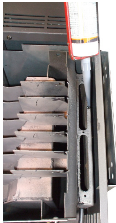
Fig. 54 - Colocação de silicone
