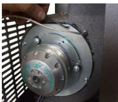
Fig. 47 - Nettoyage de l'aspirateur des fumées: phase 1
