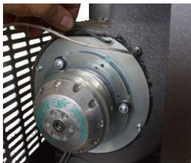
Fig. 49 - Limpieza del aspirador de humos: fase 1
