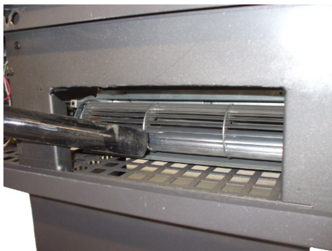
Fig. 50 - Limpeza do ventilador ambiente
