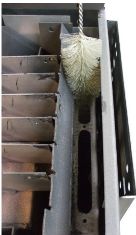
Fig. 55 - Καθαρισμός καναλιών καυσαερίων
