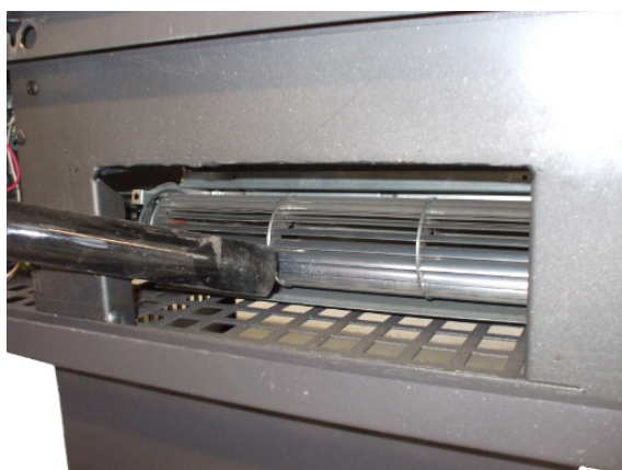
Fig. 52 - Pulizia ventilatore ambiente
