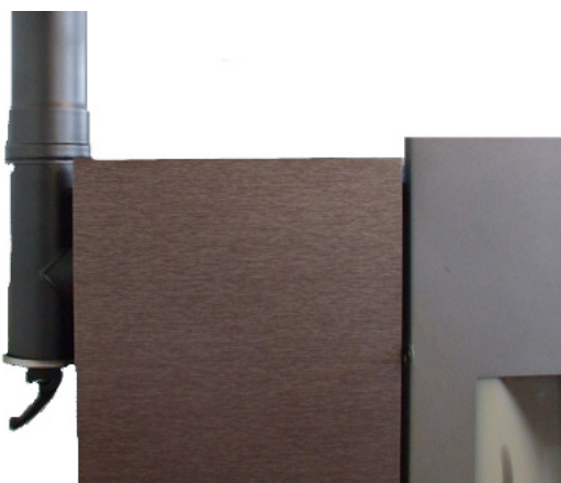
Fig. 46 - Nettoyage du conduit de fumée
