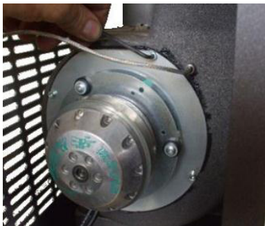
Fig. 49 - Καθαρισμό ανεμιστήρα καυσαερίων : Φάση 1
