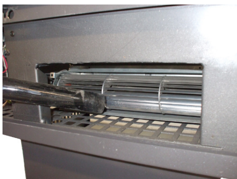
Fig. 52 - Room fan cleaning
