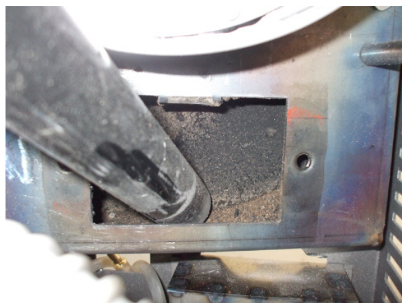
Fig. 47 - Καθαρισμός θαλάμου καυσαερίων
