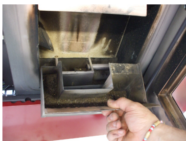
Fig. 40 - Extracción del cajón de cenizas
