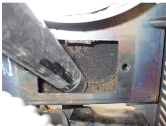
Fig. 47 - Reiniging rookgassenkamer
